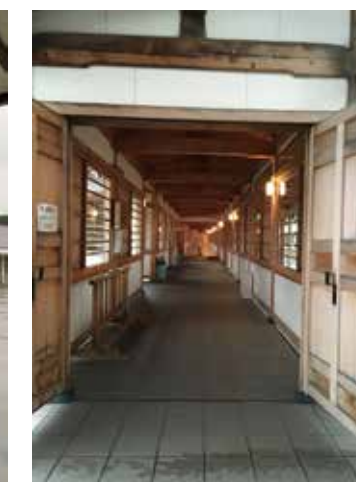
本堂へ続く回廊
